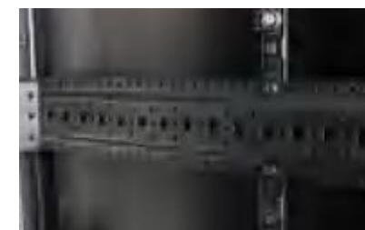
Viga de montaje de sección trapezoidal para mayor resistencia estructural
